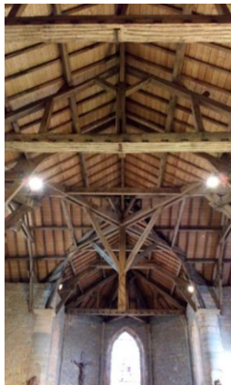
La toiture refaite à neuf
